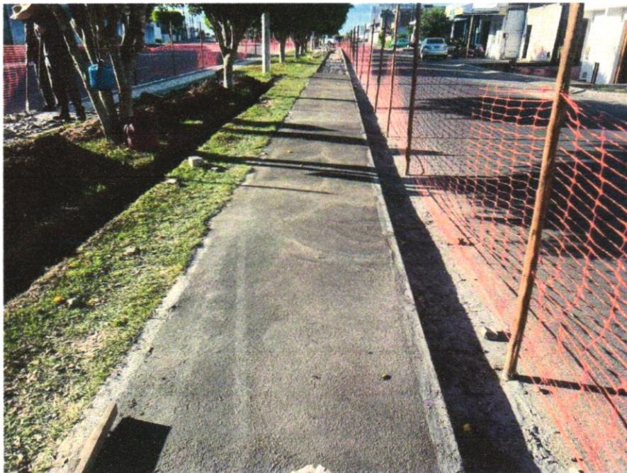
Foto 07 - PAVIMENTAÇÃO EM CONCRETO, COM ESPESSURA DE 7 CM, COM ACABAMENTO FEITO UTILIZANDO ALISADORA DE CONCRETO (HELICOPTERO), INCLUIDO TELA DE AÇO SOLDADA NERVURADA CA60, Q196 (3,11 KG/M 2 ), DIÂMETRO DO FIO 5.0 MM, LARGURA = 2,45 M, ESPAÇAMENTO DA MALHA = 10 X 10 CM, JUNTA DE DILATAÇÃO EM PVC A CADA 2,00 M, CONCRETO FCK = 20 MPA
