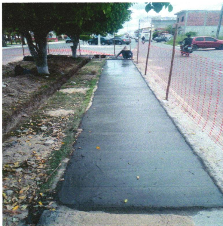
Foto 08 - PAVIMENTAÇÃO EM CONCRETO, COM ESPESSURA DE 7 CM, COM ACABAMENTO FEITO UTILIZANDO ALISADORA DE CONCRETO (HELICOPTERO), INCLUIDO TELA DE AÇO SOLDADA NERVURADA CA60, Q196 (3,11 KG/M 2 ), DIÂMETRO DO FIO 5.0 MM, LARGURA = 2,45 M, ESPAÇAMENTO DA MALHA = 10 X 10 CM, JUNTA DE DILATAÇÃO EM PVC A CADA 2,00 M, CONCRETO FCK = 20 MPA
